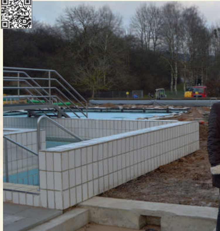
Renate Thieme, Britta Koenzgen und Hans-Jörg Göricke nehmen den aktuellen Fortschritt der Baumaßnahmen unter die Lupe. Foto: cao
