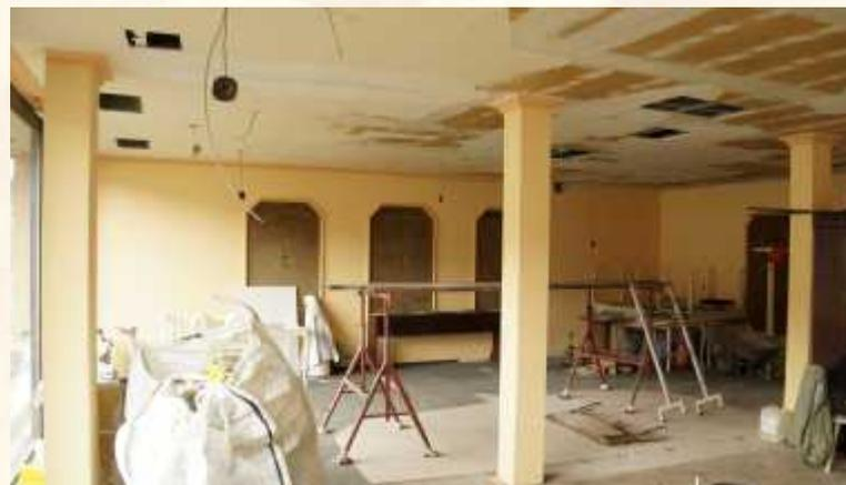
Oben ist das Loch im Boden verschwunden, wo einst eine große Wendeltreppe in das Erdgeschoss führte. Dadurch wird der Saal bedeutend größer. Foto: rus
